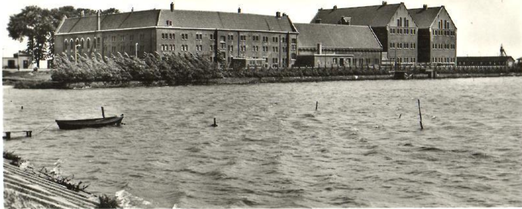
Hoorn, Strafgevangenis Oostereiland „De krententuin” oorspronkelijk admiraliteitsmagazijnen
